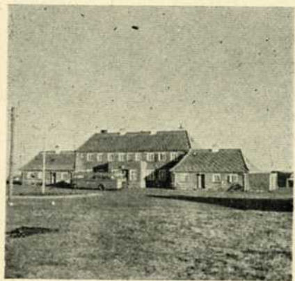
Nuværende stationsbygning i Hirtshals er imponant
