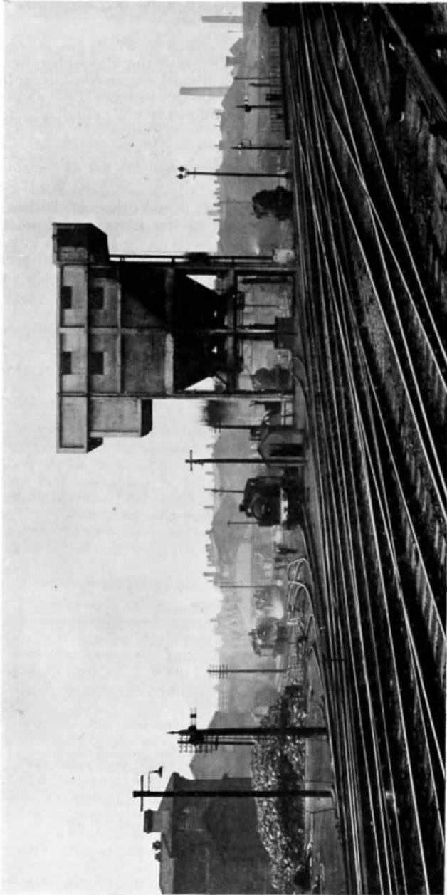
FIG. 266.—LOCOMOTIVE YARD AT LEEDS, L.M.S.R., SHOWING MECHANICAL COALING PLANT.
