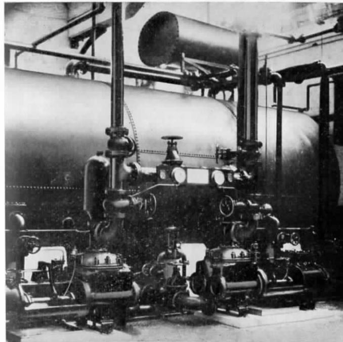
FIG. 3.—EXAMPLE OF ECONOMICAL SINGLE-TANK HOT-WATER BOILER WASHING-OUT PLANT.
