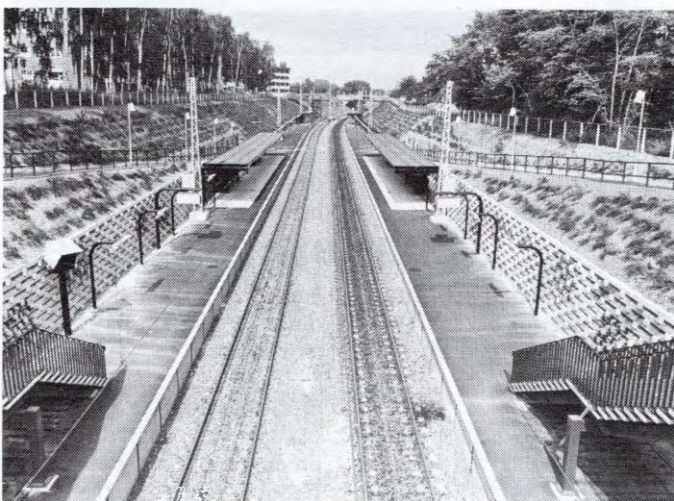
Emdrup station med støttemure, der går under betegnelsen »knoglemure«. De minder nemlig om den stabling af knogler af 4000 kapucinermunke, der findes under kirken »Santa Maria della Concezione« i Rom.
