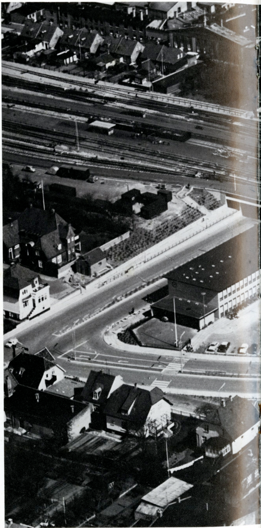
I mange tilfælde udfører baneafdelingen i forbindelse med egne anlæg også arbejder for andre myndigheder. Nykøbing FI kan tages som et eksempel herpå. Billedet viser en ny hovedbygning med ny perron- og sporanlæg, nyt posthus, ny vejunderføring, ny brovej med forbindelse til Lolland og ny forplads med rutebilstation.
