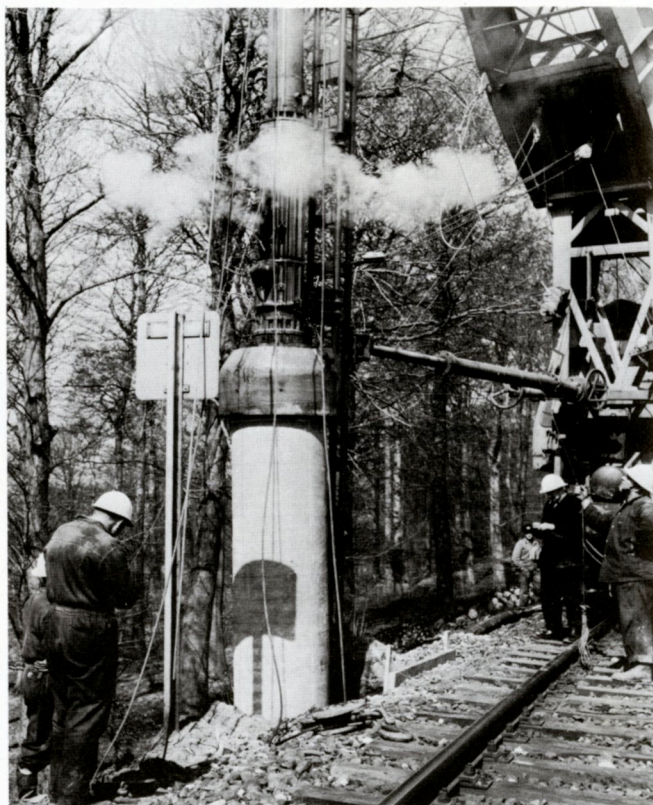
For at køreledningsmasterne kan stå solidt, må funderingen være i orden. Her nedrammes på Holte-Hillerødbanien et betonrør, hvori en køreledningsmast senere vil blive faststøbt.
