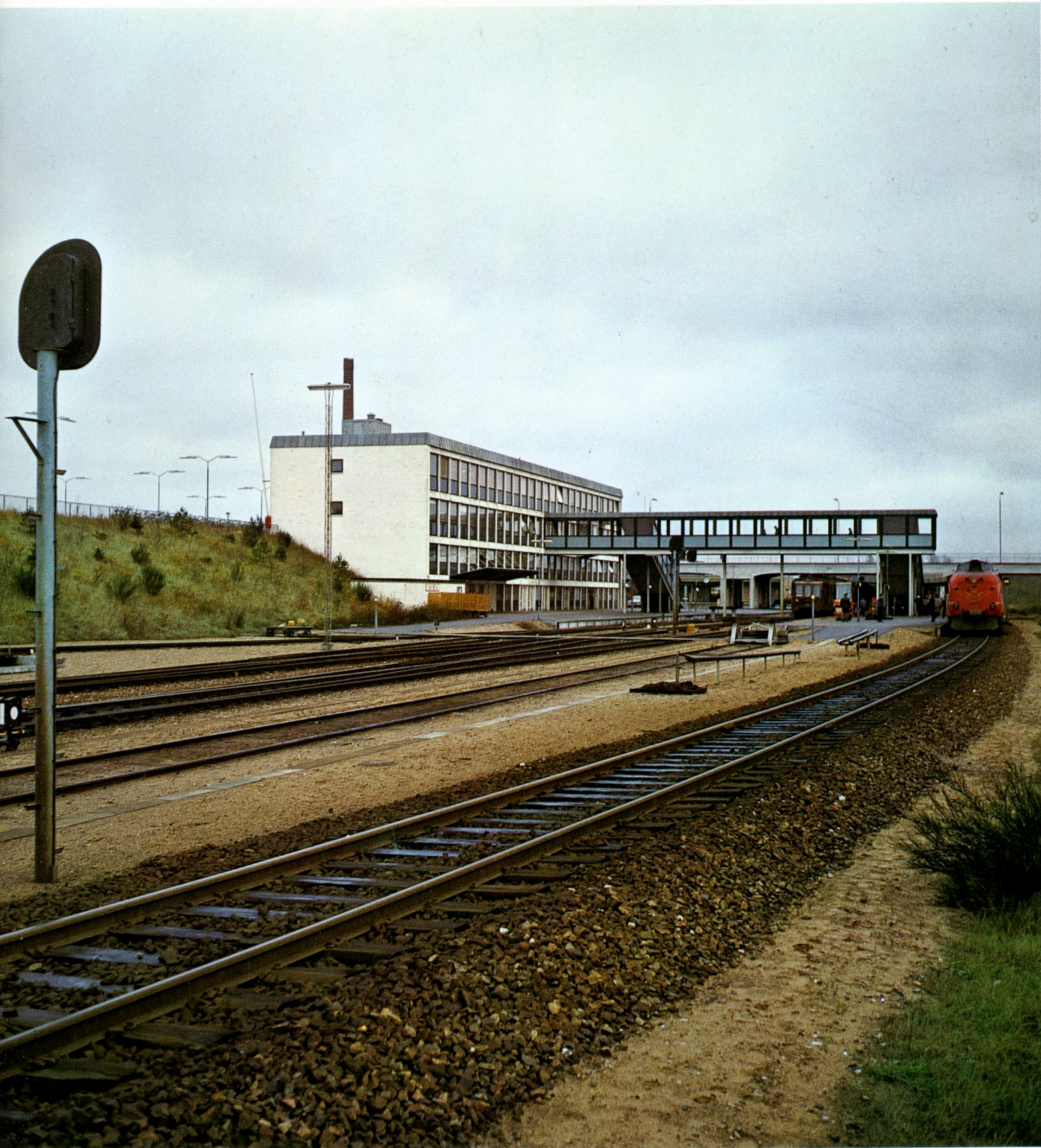
Skive H station blev taget i brug i foråret 1962. Den store terrænforskel mellem forplads og spor har givet bygningen den særlige udformning med 2 etager mod forpladsen og 4 etager mod sporsiden. Adgangen fra forhallen til perronerne sker derfor ad en forbindelsesbro med trapper til de enkelte perroner.
