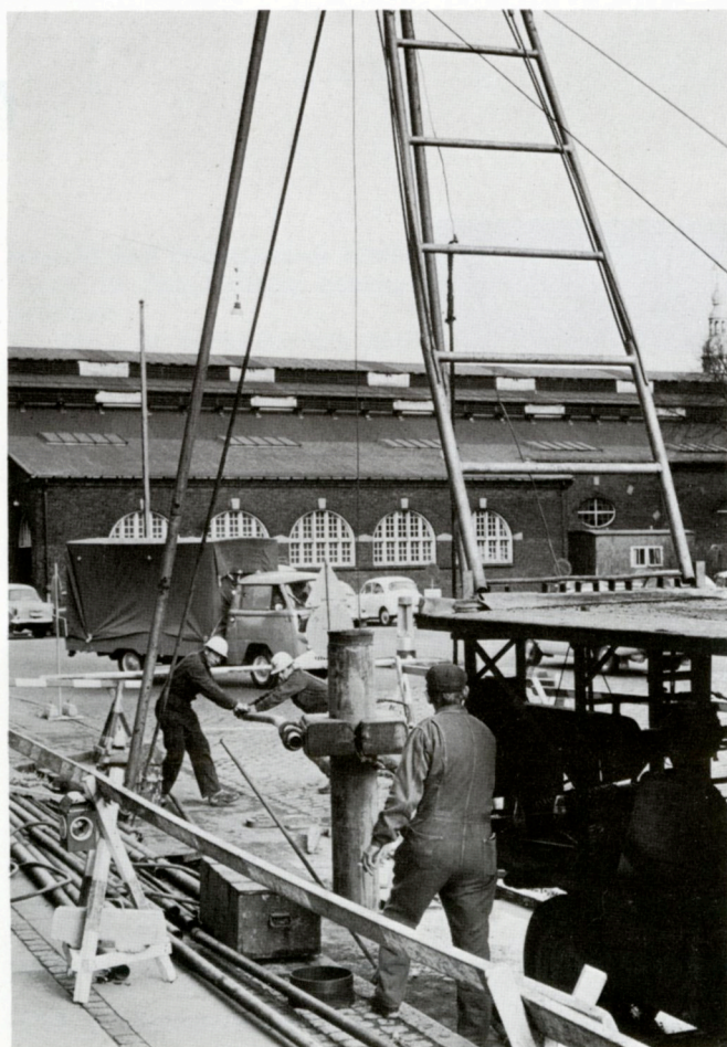
For at køreledningsmasterne kan stå solidt, må funderingen være i orden. Her nedrammes på Holte-Hillerødbanien et betonrør, hvori en køreledningsmast senere vil blive faststøbt.
