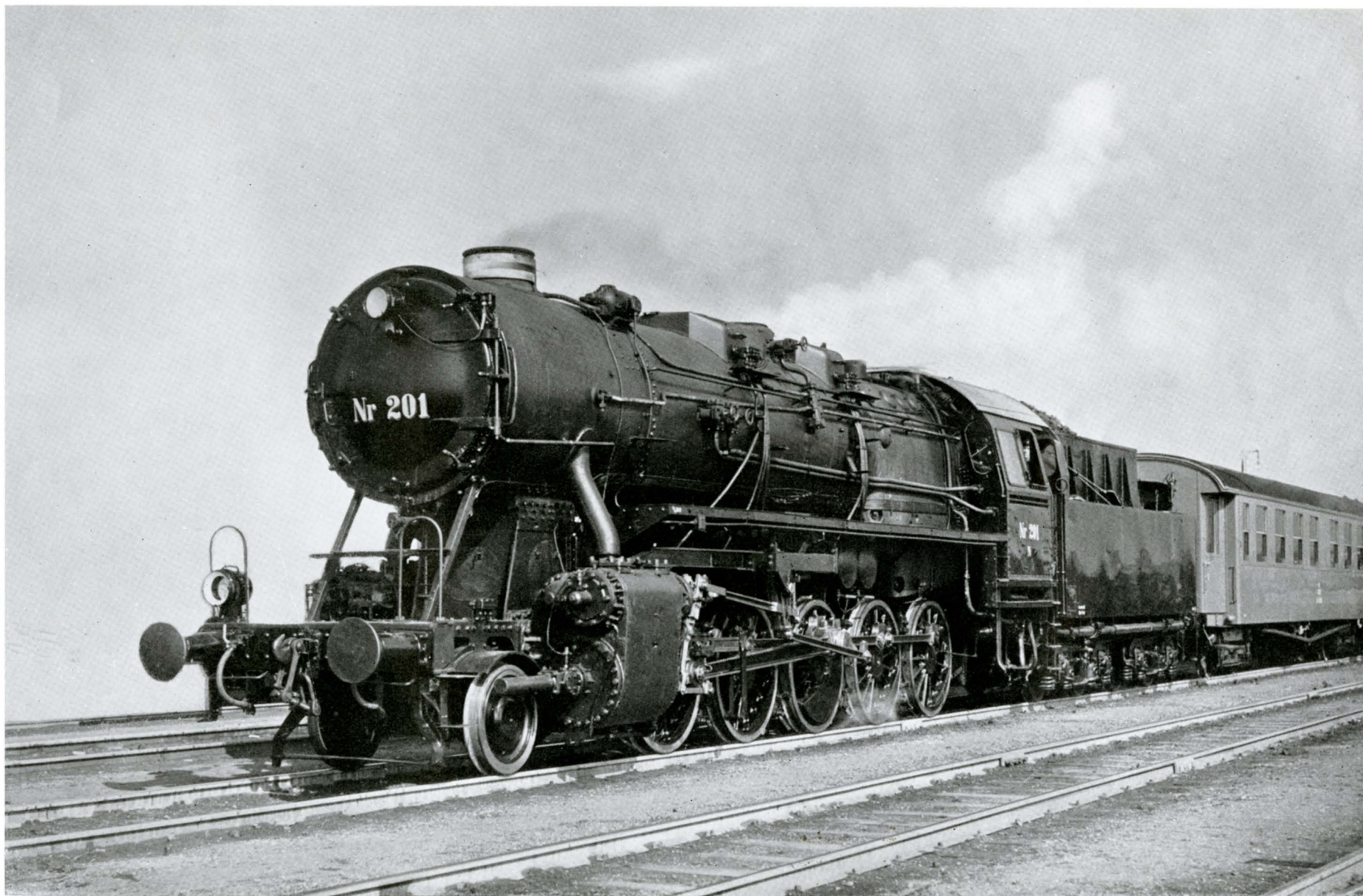
Godstogslokomotiv litra N. Bygget i Belgien 1943. Vægt 87 + 56. Kedeltryk 15 atm. Rist 3,9 m 2 . Overheder. Cylindre 600 × 660. Drivhjul 1404. Maksimalhastighed 70 km/t. Trækkeevne: godstog på 1200 tons med 60 km's fart på vandret bane.
