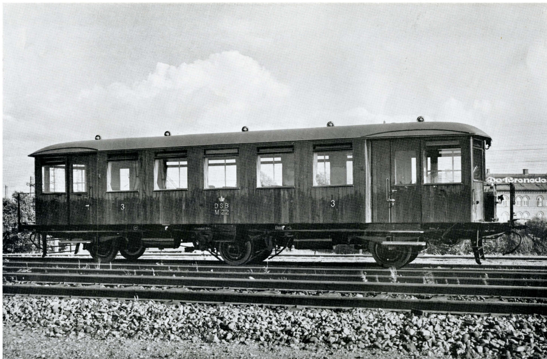
Benzinmekanisk motorvogn litra MC. Nr. 611—612 bygget 1926 af De forenede Automobilfabrikker, Odense. Vægt 21. Max. togvægt 48. Max. hastighed 55 km/t. Har en 6 cyl. „Continental“ benzinmotor i hver ende af vognen, der hver udvikler maksimalt 100 HK ved 2000 O/M. Kraften overføres mekanisk gennem gearkasse til det mellemste hjulsæt. Vognen er 3-akslet med 50 siddepladser og plads til 0,5 ton gods. Der er trykluftbremse og varmtvandsvarmeanlæg (koks). Vognen er udrustet med centralpuffer, og blev anskaffet til pendulkørsel på Risskovbanen ved Aarhus og var derfor, på grund af de mange standsninger der, indrettet således, at den havde stor accelerationsevne. Begge vogne er udrangeret.
