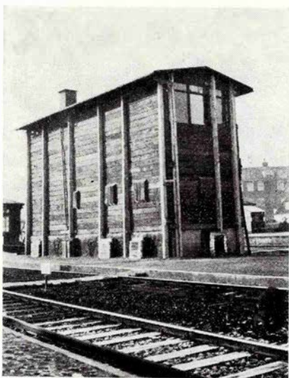
Kommandoposten i Hellerup 1942—48 klædt i rustning af brugte sveller til værn mod flyverbomber.
