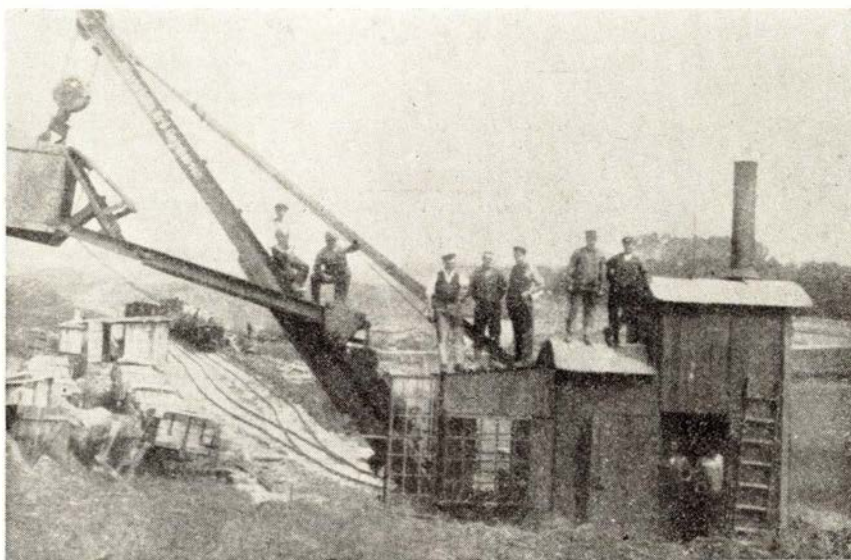
Anlægsarbejder i nærheden af Hvalsø
