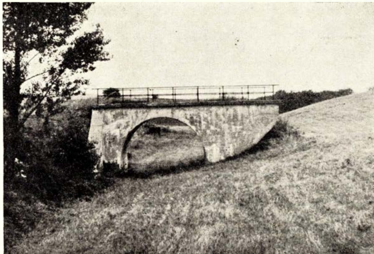
Viadukt for St. Merløse—Hvalsø — vejen ender nu brat
