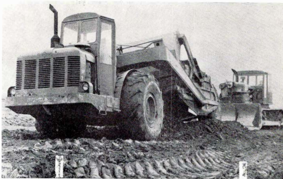
Fig. IX. Scrapers, der samler jorden som i en rom efterfulgt af bulldozer.
