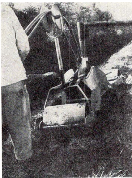
Fig. 2. Kabelploven i arbejde. Ploven trækkes via en 200 m stålwire af et 5–10 r's spil. Den styres ved en hydraulisk bevægelse af forram- men.
