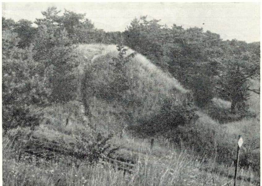
HAJ overføring over DSB ved Over-Jerstal
