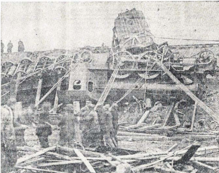
P-maskinen væltes ned på engen, hvor den blev rejst på højkant og trukket op til Vigerslev st. på et midlertidigt spor, der var lagt på langs ad dæmningen
