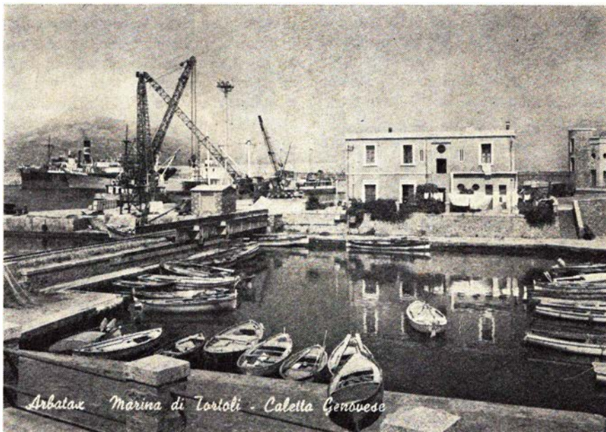
Den nuværende station i Arbatax med vasketøj på perronen
