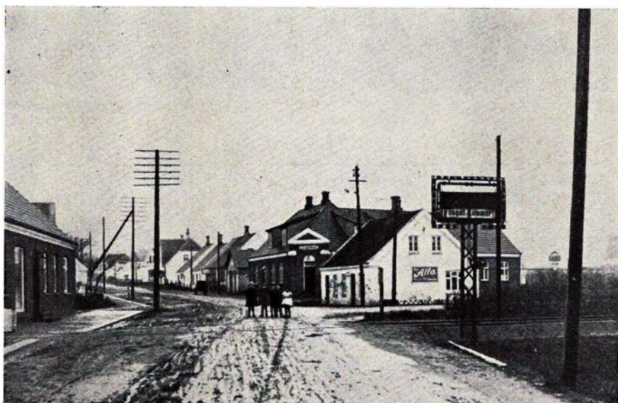
Overskæringen i Tårs 1926. T.h. advarselsskilt, der normalt var dækket af en plade, der ved kædetræk hejstes op for: Toget kommer.
