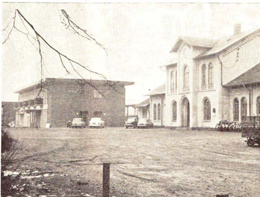
Ny station til venstre, den gamle til højre
