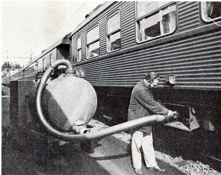
Vognens vacuumtoiletbeholder tømmes på endestationen
