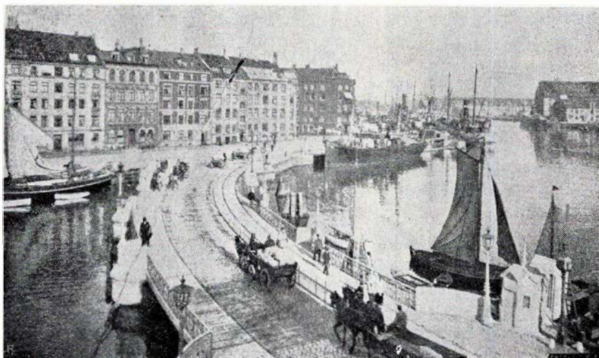
Børsbroen med sporforbindelse til Havnegade 1880-1933
