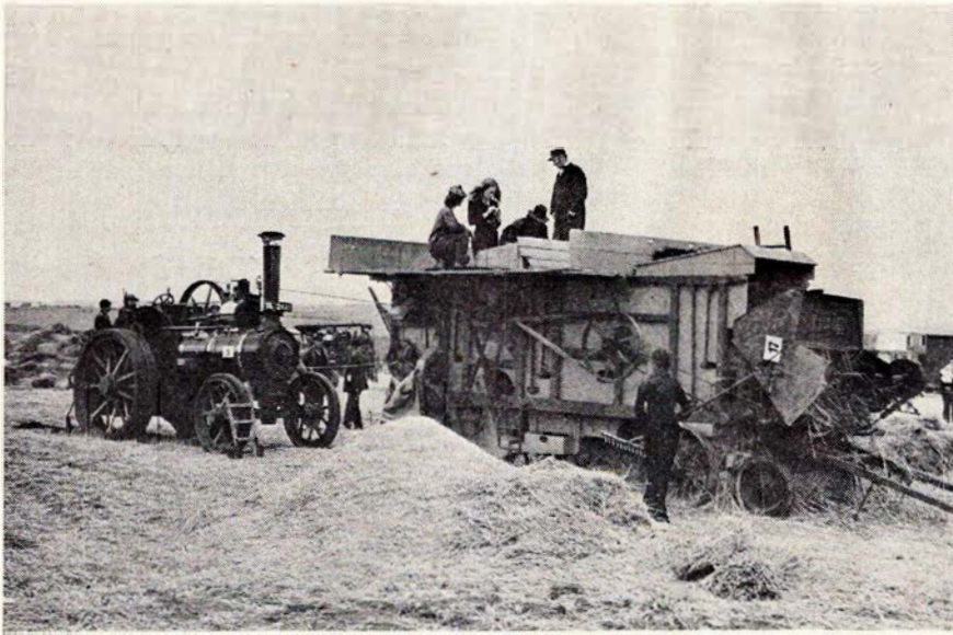
Lokomobiltrukket tærskværk arbejder på en »Steam Cavalcade« i England i 1972. Foto: -tl-
