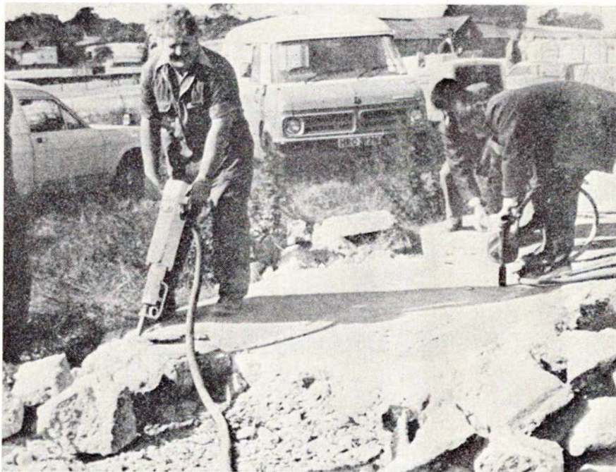
Betonhammeren »PACEBRAKER« i aktivitet i betondække.
